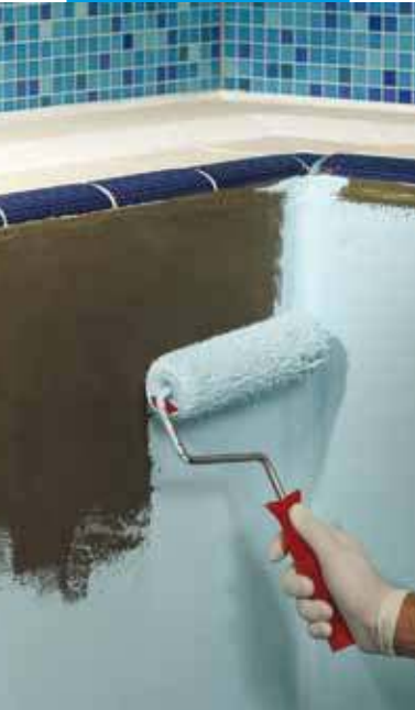
Нанесение Elastocolor Waterproof валиком
