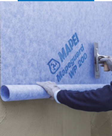
Укладка Mapeguard WP 200
