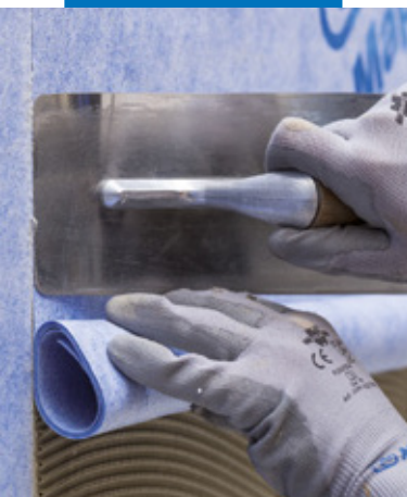
Укладка второго листа
