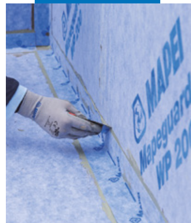
Наклеивание ленты Mapeguard ST
