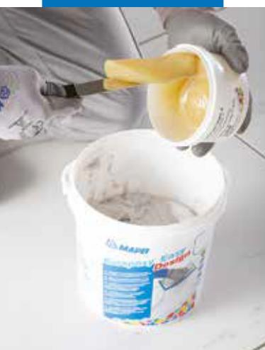
Переложите отвердитель (компонент В) в емкость с компонентом А
