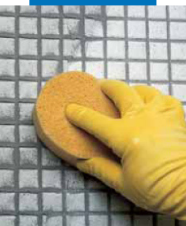
Очистка стеклянной мозаики губкой
