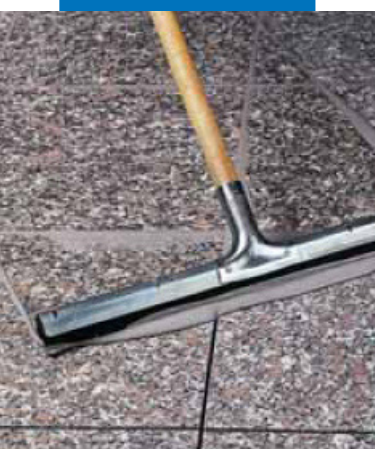
Заполнение швов в гранитных полах резиновой раклей
