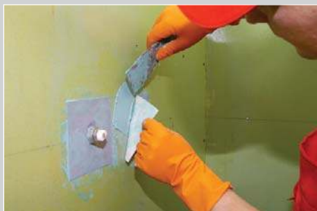
Герметизация выпуска трубы пластырем LITOBAND S
