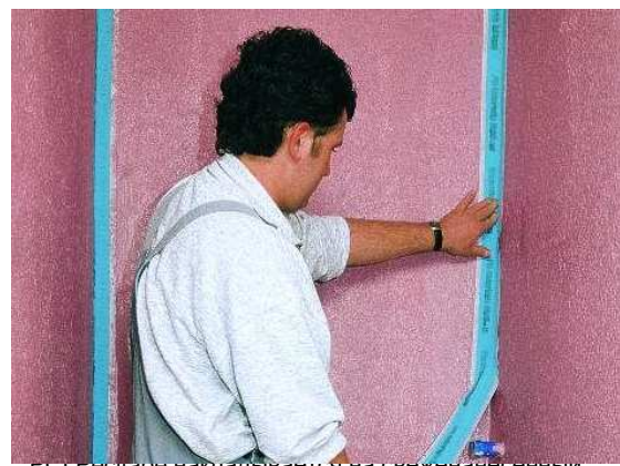
PCI Pecitape накладывается на свеженанесенный слой герметика.
