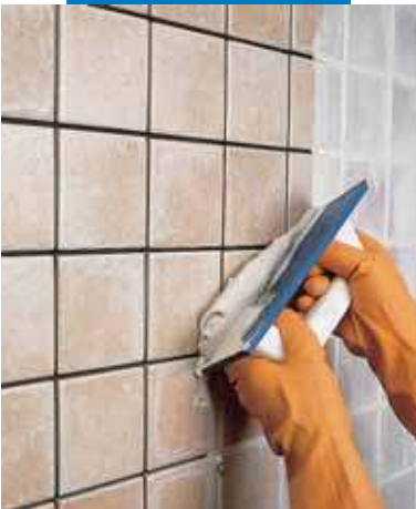
Заделка швов плитки одинарного обжига мастерком
