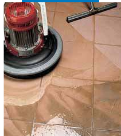
Отделка фаянсовых полов моющеткой со скребком
