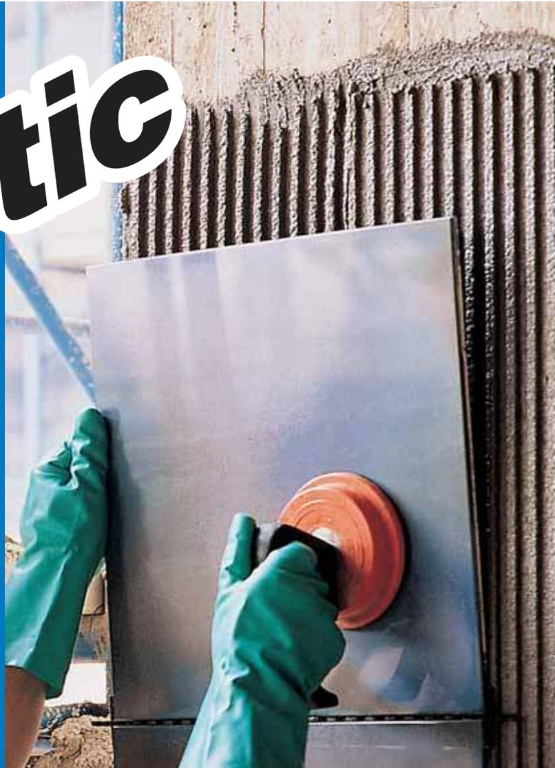
**Isolastic** представляет собой добавку для смешивания с составами **Kerabond T**, **Kerafloor** или **Adesilex P10** для улучшения их характеристик и эластичности, что приводит их в соответствие с требованиями класса C2 (улучшенный клей) согласно Евронорме EN 12004, а также класса S1 (эластичный клей) или класса S2 (высоко эластичный клей) в соответствии с Евронормой EN 12002, в зависимости от использования, в чистом виде или разбавленном с водой.
