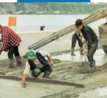
Цементная стяжка снаружи помещений с добавлением Planicrete
