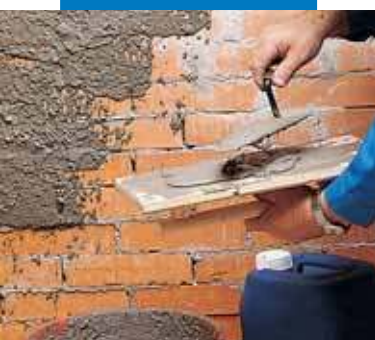
Связующий штукатурный слой с добавлением Planicrete
