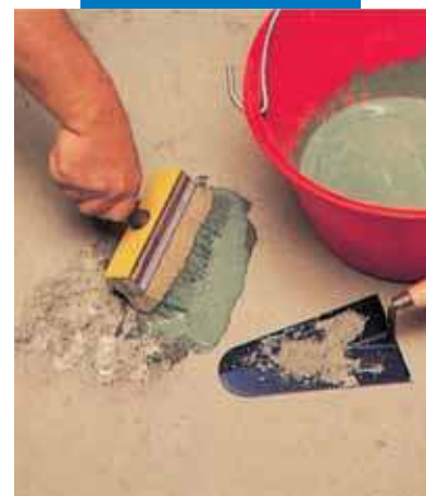
Ремонт пола с нанесением адгезионного слоя
