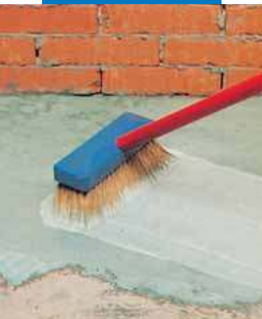
Нанесение адгезионного цементного раствора с добавлением Planicrete
