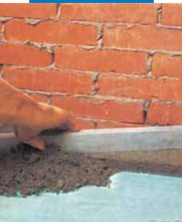
Укладка цементной стяжки с добавлением Planicrete
