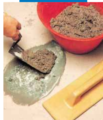
Ремонт пола: нанесение строительного раствора
