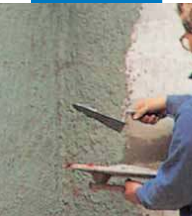
Нанесение цементных составов с добавлением Planicrete
