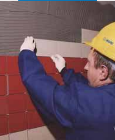
Укладка керамической плитки на стену
