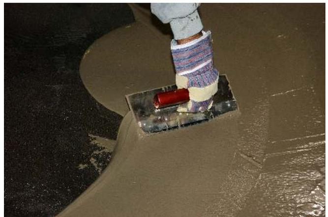
Укладка PCI Apoflex на прогрунтованное основание
