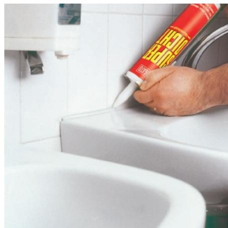
Долгосрочная и эластичная герметизация швов на раковине.
