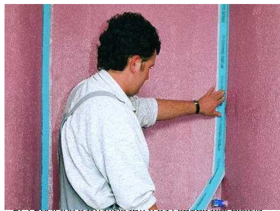
PCI Pecitape накладывается на свеженанесенный слой герметика.
