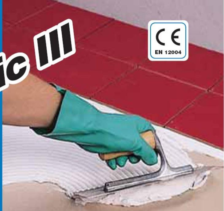
**Высококачественный готовый к применению клей пастообразной консистенции без вертикального оползания и с увеличенным открытым временем, применяемый для укладки керамической плитки на полы и стены.**
