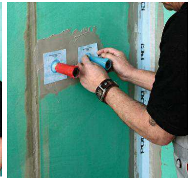
4. Наклейте PCI® Pesticare 10x10 на трубные соединения, выступающие из стены, и покройте PCI® Lastogum (серый).
