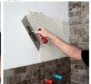
6. Когда водонепроницаемый PCI® Lastogum затвердел, можно укладывать плитку.
