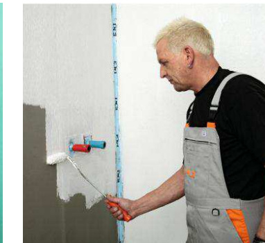
5. После высыхания примерно через час нанесите второе защитное покрытие PCI® Lastogum (белый). Первое покрытие PCI® Lastogum (серый) не должно просвечивать, иначе может потребоваться еще один слой.
