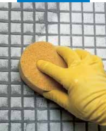
Отделка стенового покрытия из стекломозаики губкой
