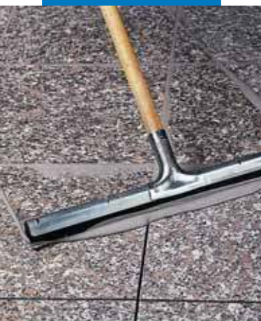
Шпаклевка полового покрытия из полированного гранита скрбком
