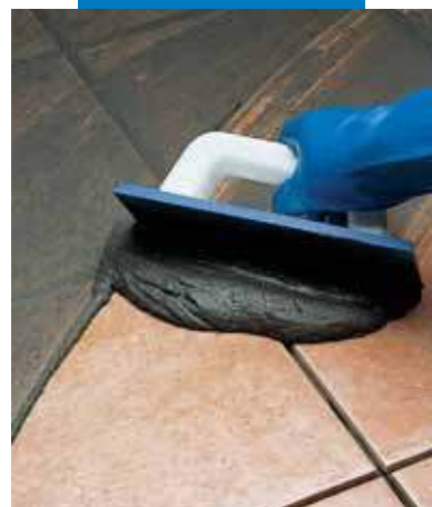
Шпаклевка плитки одинарного обжига шпатлем
