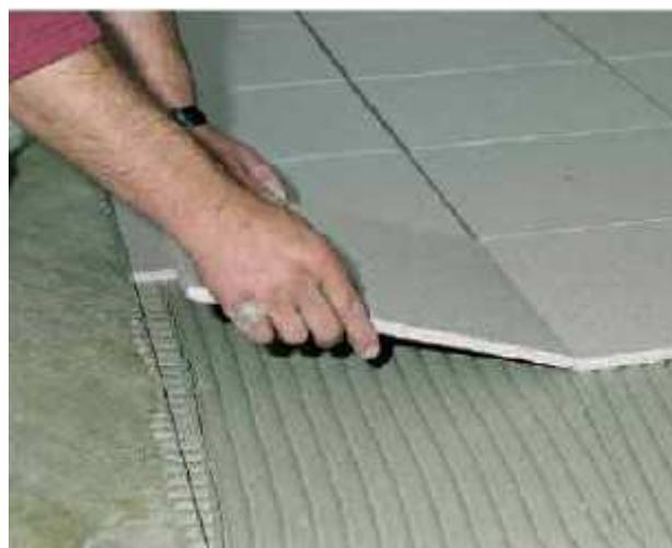
PCI Nanoflott применяется в качестве балластного слоя при укладке плитки, а также в качестве традиционной мастики.
