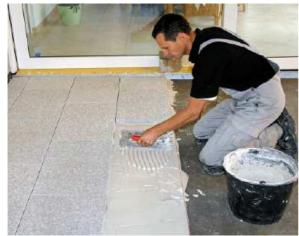
Надежная укладка плит из натурального камня, подверженного окрашиванию или деформации, с помощью белого клея PCI<sup>®</sup> Carraflott NT.
