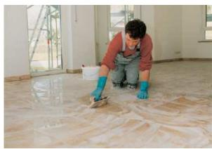
Для плит из натурального камня использовать затирку для швов  ${\rm PCI}^{^{(8)}}$  Carrafug. Швы примыкания пола к стене уплотнить силиконовым герметиком  ${\rm PCI}^{^{(8)}}$  Carraferm.
