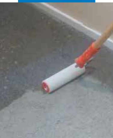
Нанесение Primer G валиком
