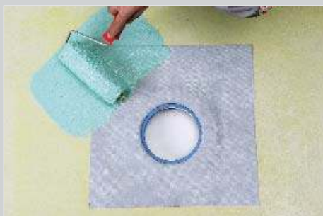
Герметизация сливного трапа пластырем LITOBAND P
