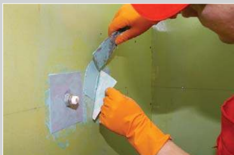
Герметизация выпуска трубы пластырем LITOBAND S
