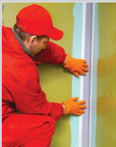
Герметизация стыка "стена-стена" лентой LITOBAND R
