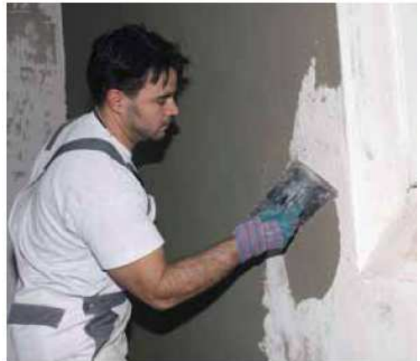
PCI Pericret удобен в применении – может наноситься с толщиной слоя от 3 до 20 мм.
