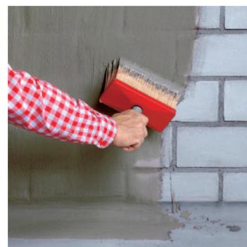
Гидроизоляция с помощью смеси "сухой подвал" - здесь на известняковой стене.
