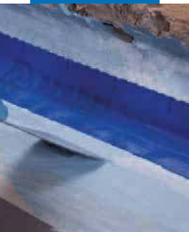
Укладка Mapeband на галтель примыкания стена-пол с помощью Mapelastic AquaDefense
