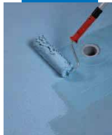
Нанесение валиком второго слоя Mapelastic AquaDefense
