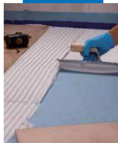
Укладка плитки поверх Mapelastic AquaDefense
