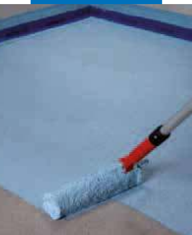
Нанесение первого слоя Mapelastic AquaDefense на стяжку
