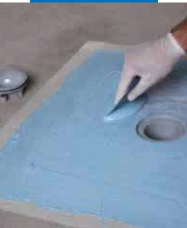
Пропитка полотна Drain Vertical при помощи Mapelastic AquaDefense
