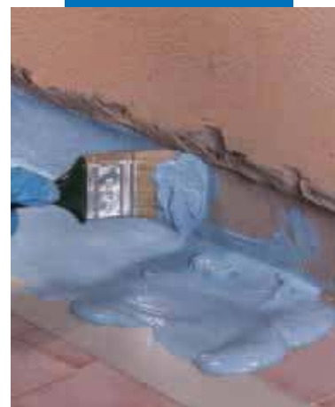
Нанесение кисточкой Mapelastic AquaDefense в углу примыкания пола и стены перед нанесением Mapeband
