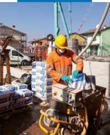
Перемешивание в смесителе Novoplan Maxi R
