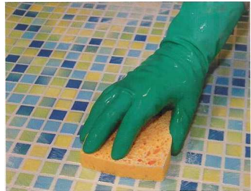
Промывка керамического покрытия при помощи мягкой губки PCI Epoxi-Schamm fein
