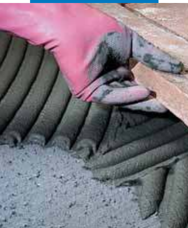
Укладка терракоты на неровное основание
