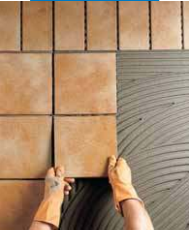
Укладка клинкерной плитки снаружи помещений
