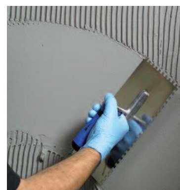
Нанесите второй слой гидроизоляции при помощи шпателя
