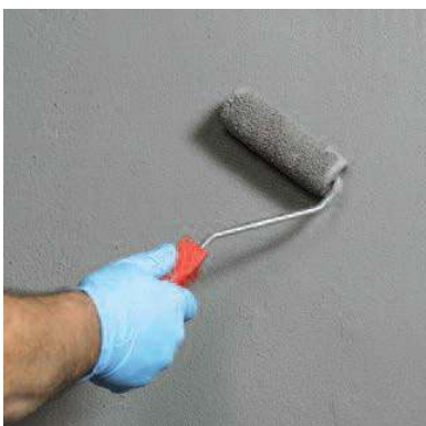
Нанесите на всю площадь первый слой гидроизоляции Seccoral 2K Rapid при помощи валика
