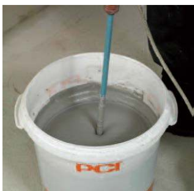
Перемешать оба компонента при помощи низкооборотистой дрели
