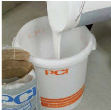
Вылить жидкий компонент PCI Seccoral 2K Rapid в чистую емкость
