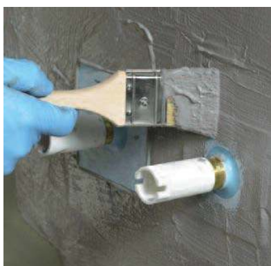
Используйте гидроизоляционную манжету в местах закладных деталей
