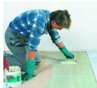
PCI Collastic пригоден для применения на чувствительных к воздействию влаги основаниях, например, на древесностружечных плитах.
