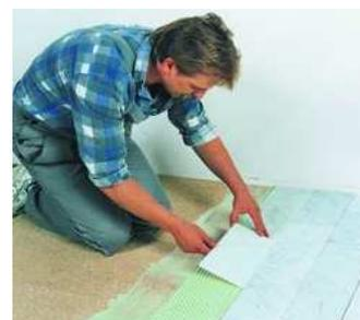
При помощи клея PCI Collastic возможна укладка мраморных плит на основания из древесностружечных плит.
