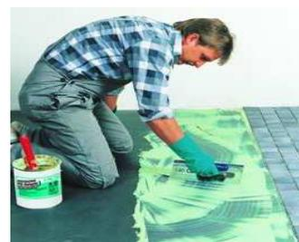
PCI Collastic можно применять при укладке керамического покрытия на листовую сталь.
