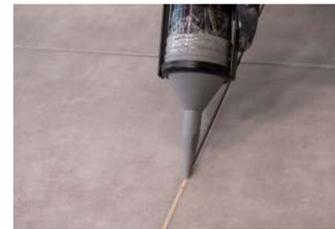
9. Затирку так же можно наносить с помощью специального пистолета, заполнив пустой картридж затирочной смесью. Этот способ нанесения идеален для работы с большой по размеру плиткой. Защитите поверхность пола если затирка наносится в межплиточное пространство на стене.
