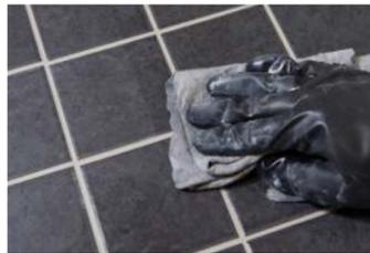
7. Вытрите поверхность с использованием сухой губки и тканевого материала.
