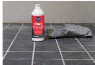
8. Если на поверхности плитки всё же останется затирка, удалите её с помощью Kiilto Epoxy Cleaner не позднее, чем через 24 часа после работы с затиркой.
