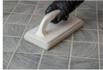
5. Промойте поверхность плитки в течение 10 минут с использованием тёплой воды и грубой губки. Избегайте использования слишком большого количества воды.
