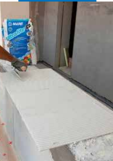
Нанесение клея на тыльную сторону плит
