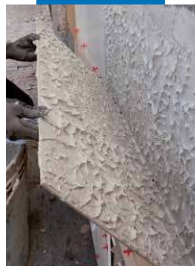
Контроль покрытия клеем тыльной стороны плит при облицовке фасада.
