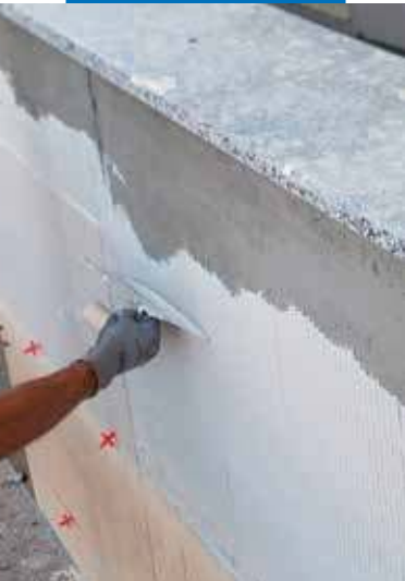
Облицовка фасада: нанесение клея на основание.
