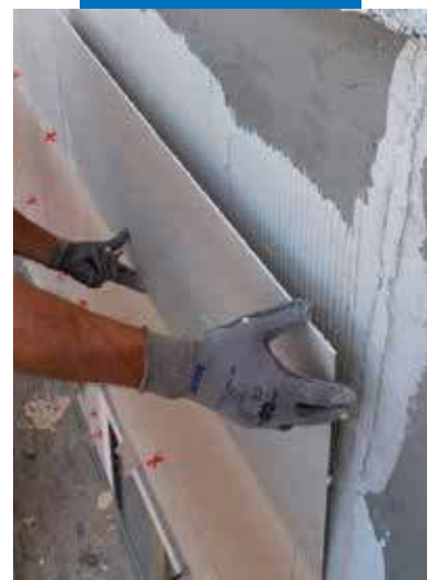
Укладка тонкого керамогранита на фасад
