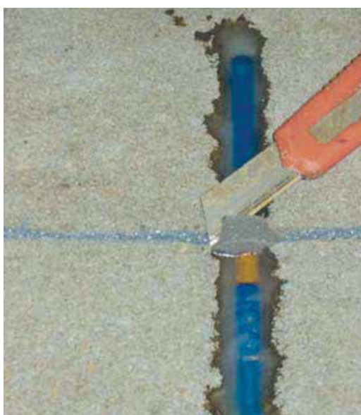
6. Отрезание излишков вспененного материала
