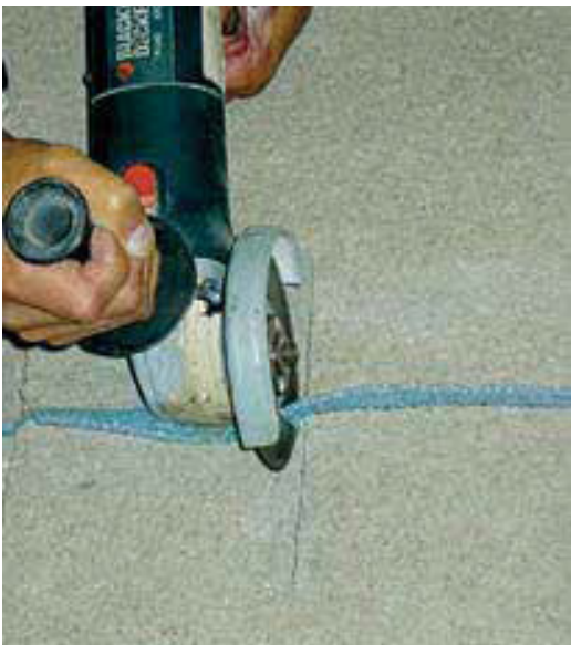
1. Создание пропила для установки дюбеля
