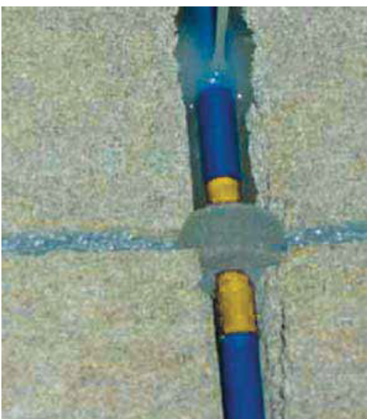
5. Заливка дюбеля смолой Ерогір или Ерогір Turbo
