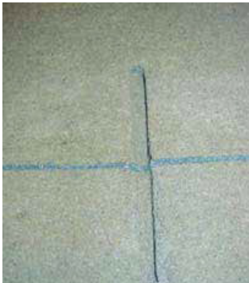
2. Пропил готов для установки дюбеля
