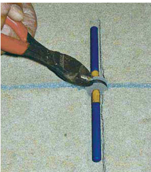
3. Удаление зажимного кольца поверх уплотняющего кольца из вспененного материала
