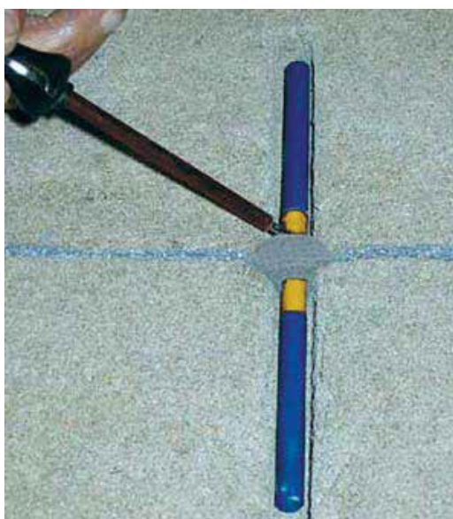
4. Регулировка дюбеля
