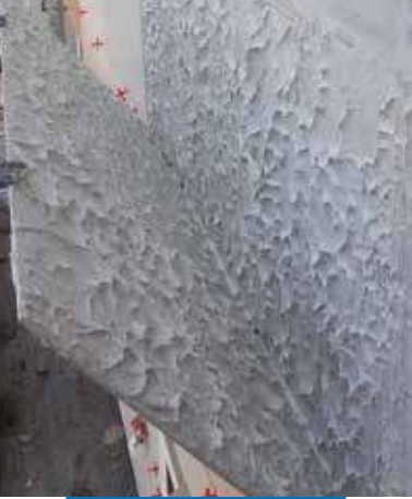
Отличное покрытие тыльной стороны плит
