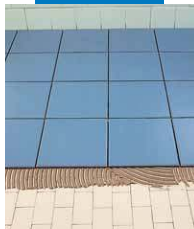
Укладка плитки с применением клея Keraflex серого цвета
