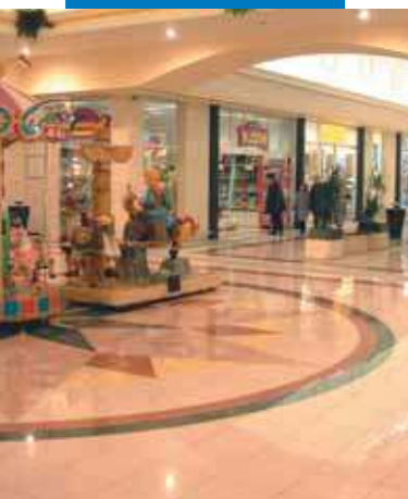
Пример укладки фарфоровой плитки в торговом центре г. Тревизо (Италия)
