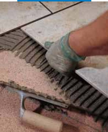
Укладка плитки одинарного обжига на стену снаружи помещения, облицованную терракцо
