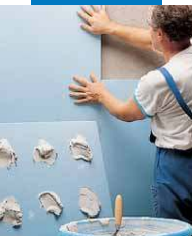
Монтаж полистироловых плит с помощью белого клея Keraflex
