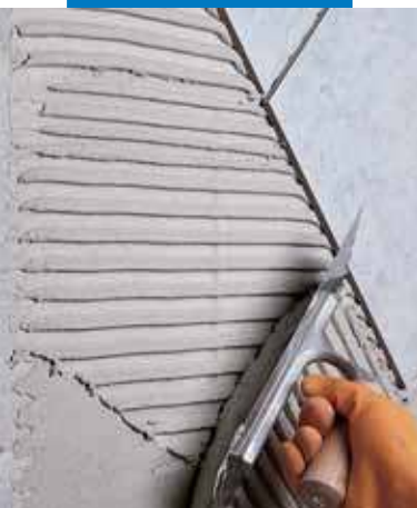
Укладка плитки одинарного обжига поверх стенки с блоками из ячеистого бетона
