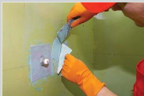
Герметизация выпуска трубы пластырем LITOBAND S
