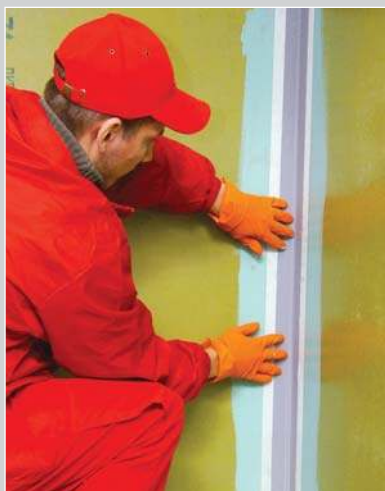
Герметизация стыка "стена-стена" лентой LITOBAND R
