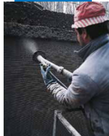
Механизированное нанесение методом мокрого торкретирования
