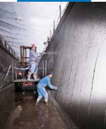
Канал гидроэлектростанции в г. Бертини-Роббьяте (Область Комо): отделка мастерком
