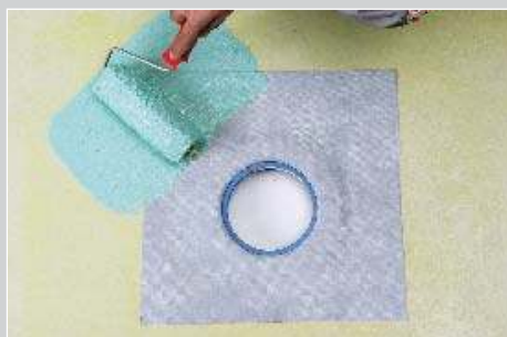
Герметизация сливного трапа пластырем LITOBAND P
