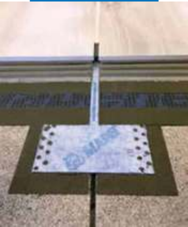
Mapeband Easy, уложенная на деформационный шов в стяжке
