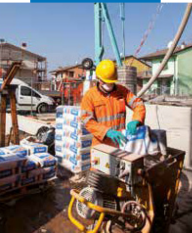
Перемешивание в смесителе Novoplan Maxi R
