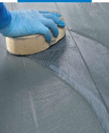
Окончательная очистка плитки с помощью целлюлозной губки
