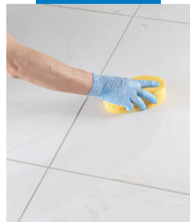
Окончательная очистка плитки с помощью целлюлозной губки
