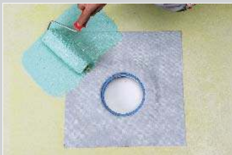
Герметизация сливного трапа пластырем LITOBAND P
