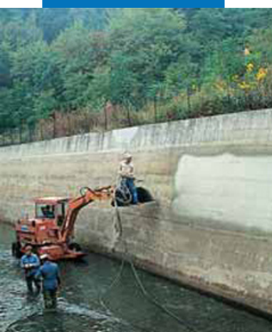
Нанесение Planiseal 88 напылением на подводный канал гидроэлектростанции
