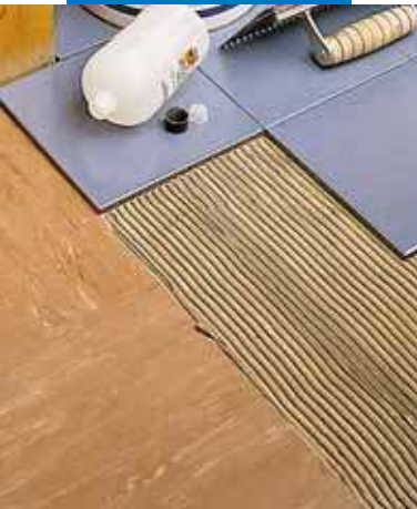
Укладка нового покрытия поверх существующего из ПВХ
