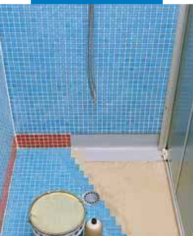
Гидроизоляция и укладка мозаики в сборно-блочной душевой кабинке
